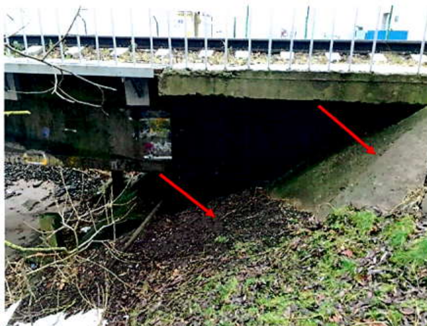
18.att. Sabrucis konusa nostiprinājums, sanesumi. Skats uz krasta balstu Nr.2. augštecē.
