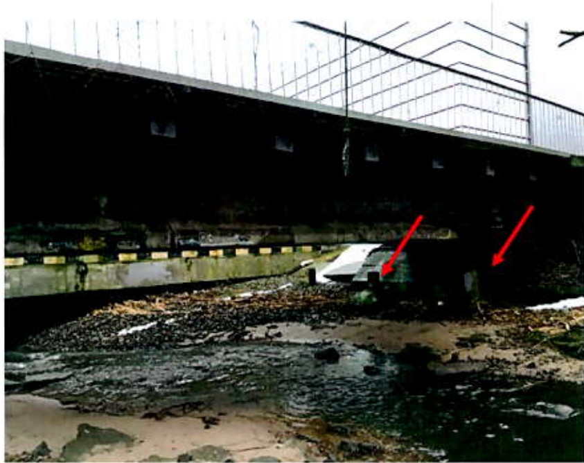
23.att. Dažādu konstrukciju atliekas pie tilta, sanesumi gultnē. Skats pie krasta balsta Nr.2.
