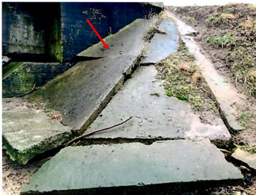
15.att. Sabrucis konusa nostiprinājums. Skats uz krasta balstu Nr.1. lejtecē.
