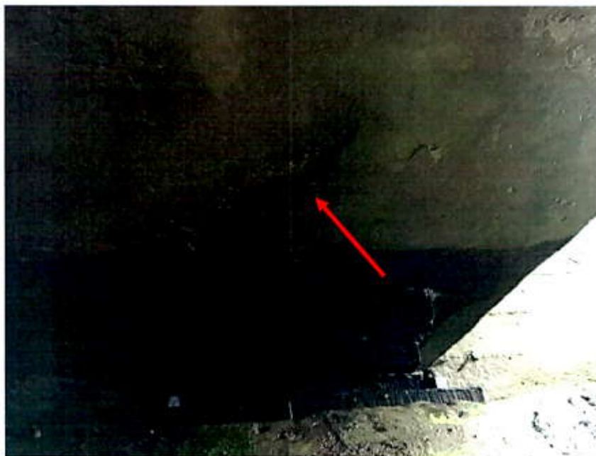
13.att. Drūp betons, korodē konstruktīvai stiegrējums. Skats pie krasta balsta Nr.1 lejtecē.
