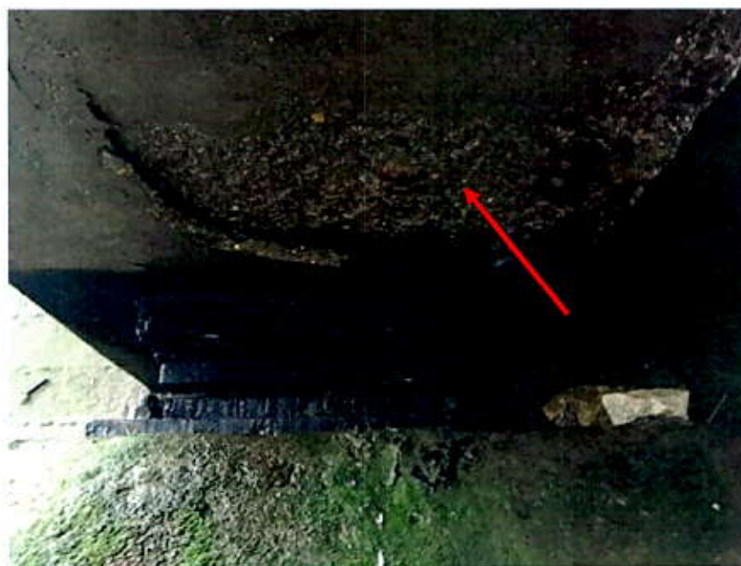
12.att. Drūp betons, korodē konstruktīvai stiegrojums. Skats pie krasta balsta Nr.1 augštecē.
