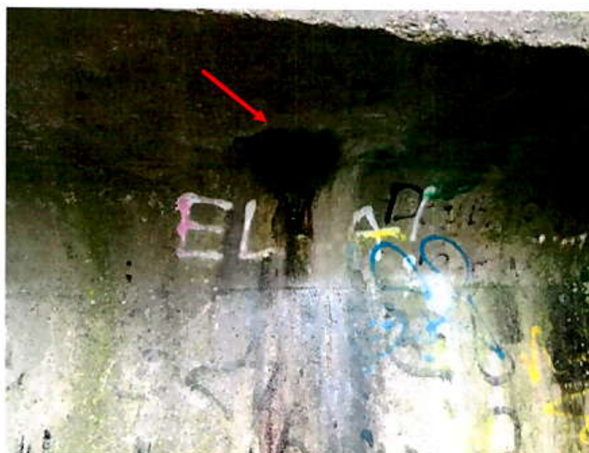
10.att. Bojātas ūdens atvades caurule, uz sijas tek ūdens. Skats lejteces pusē pie krasta balsta Nr.1.
