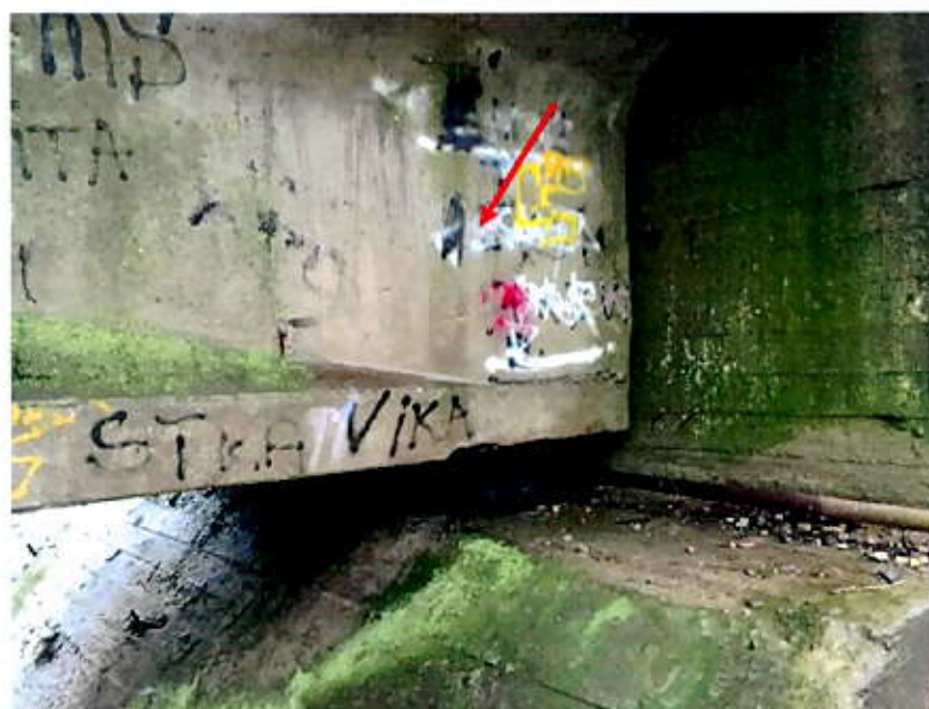
8.att. Aprakstīta tilta fasāde. Kabelis pie balstīklām. Skats no augšteces puses pie krasta balsta Nr.2.
