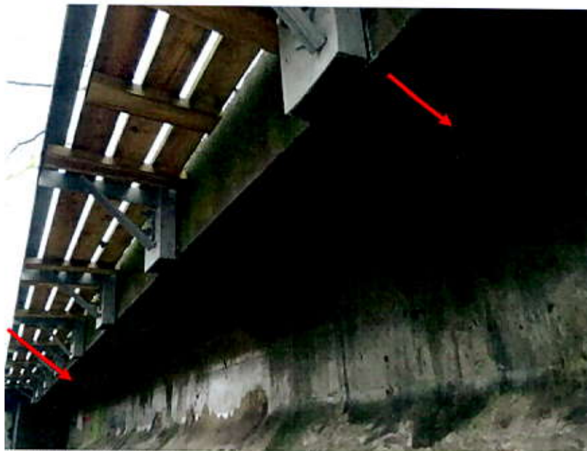
9.att. Bojātas ūdens atvades caurules. Skats augšteces pusē.
