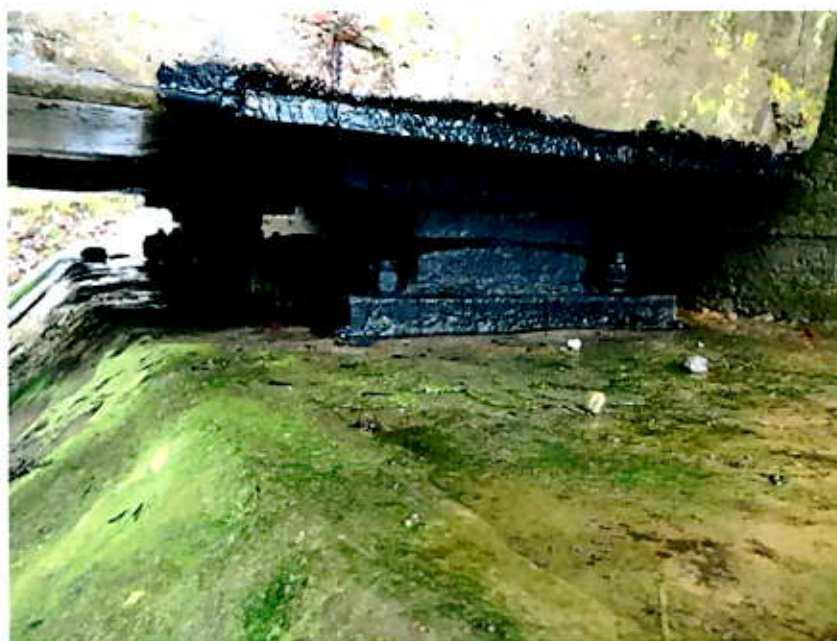
20.att. Veikta balstīklu apkope. Skats uz krasta balstu Nr.1. lejtecē.
