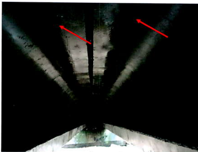
6.att. Nepietiekama garuma ūdens atvades caurules. Skats no apakšas starp laiduma sijām.
