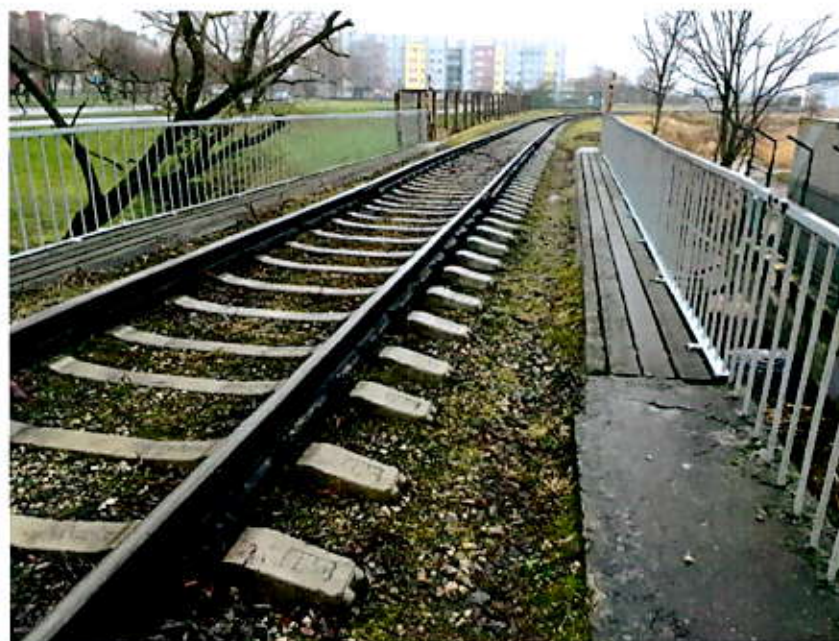
4.att. Atjaunota ietve, nokrāsotas margas. Skats lejteces pusē.
